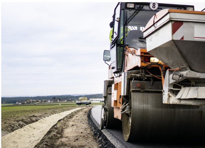
Rath Bau punktet mit einem modernen Maschinenpark.
